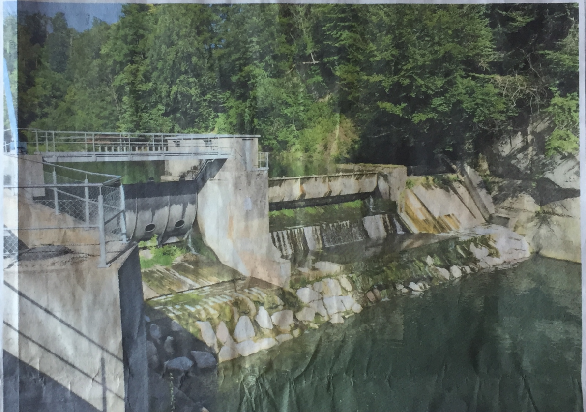
Hinsichtlich Stromproduktion hat das Wehr in Freienstein den Minusrekord von 2011 im letzten Jahr unterboten. Foto: Koni Ulrich
